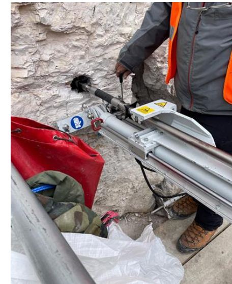
Installazione in foro orizzontale
