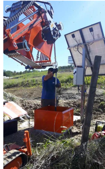
Installazione in foro verticale. Fonte: archivio ARPA Piemonte
