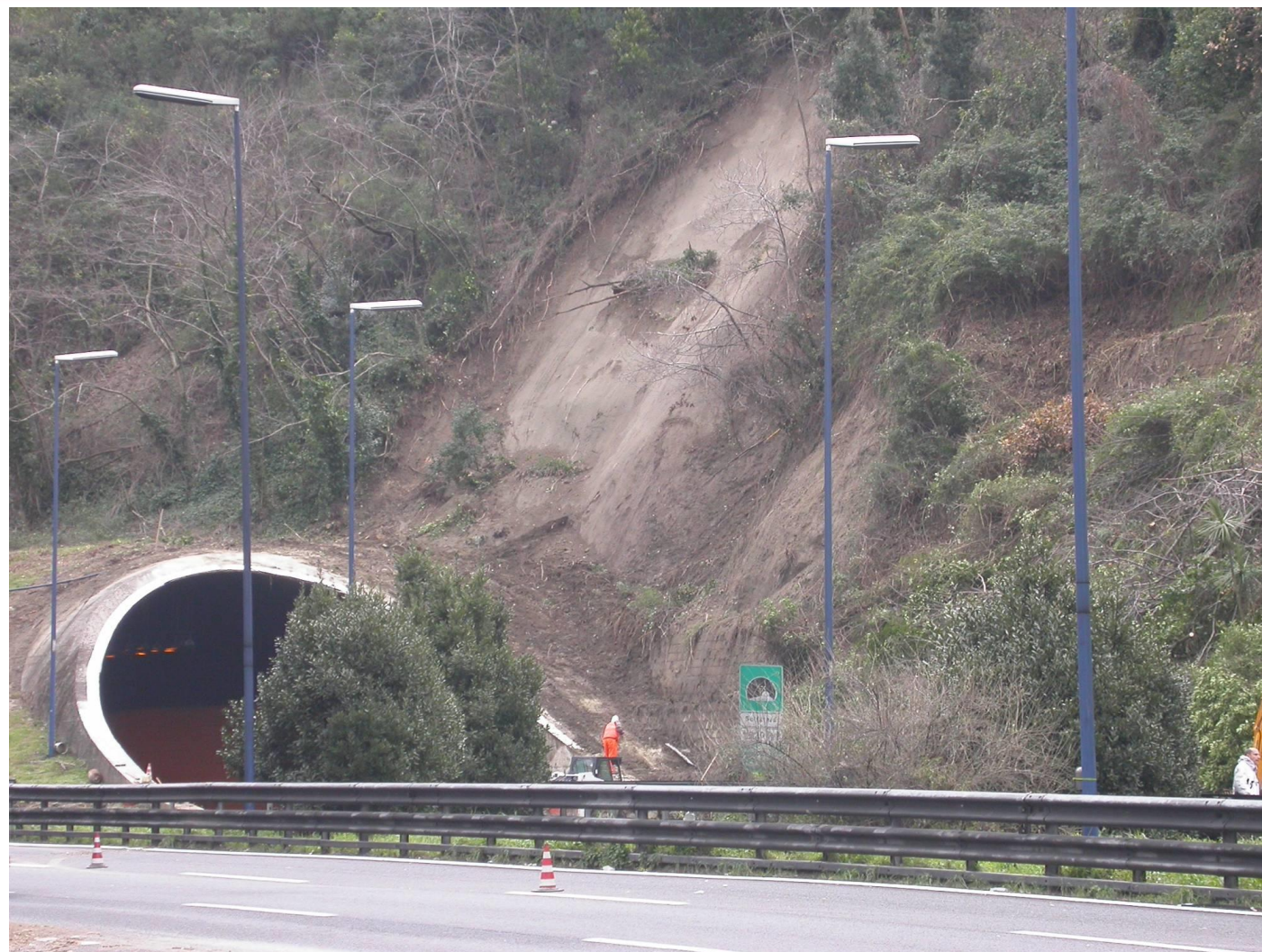
Frana lungo la tangenziale di Napoli (2005).
